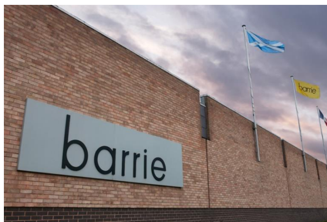
Рисунок 4. Трикотажная фабрика Barri
